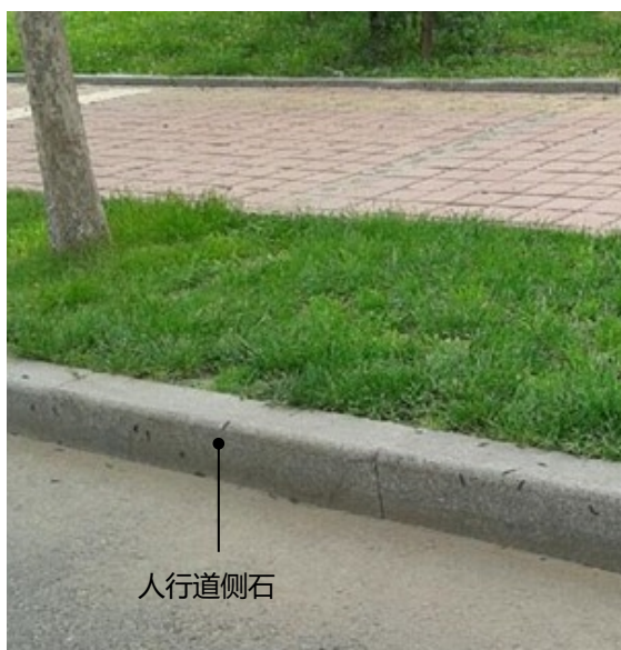
图5-19 人行道侧石示意图
